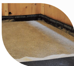
Układanie maty akustycznej
