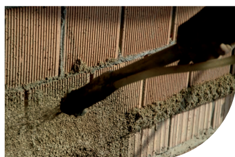
Poszczególne etapy aplikacji tynków gamy Isolteco® i Isolsan 230®
