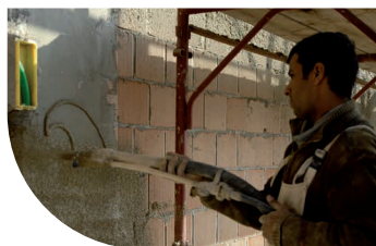
Eliminacja mostków termicznych na belkach i stupach.
