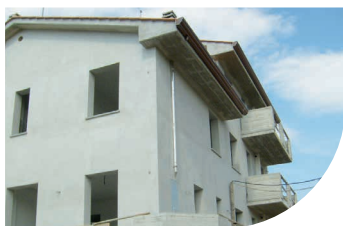
Ocieplanie ścian zewnętrznych.
