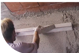
Poszczególne etapy aplikacji tynków gamy Isolteco® i Isolsan 230®
